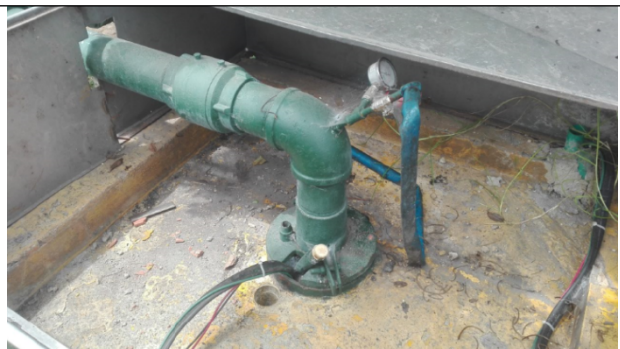
Foto No. 2 Boca del pozo pz-09-0040
