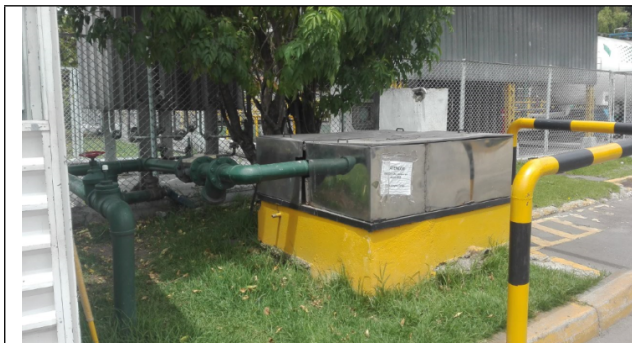
Foto No. 1 Vista general del pozo pz-09-0040.
